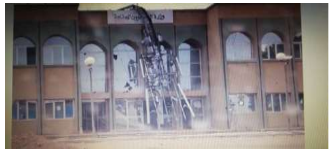
صورة (1) سقوط برج الاتصالات بسبب الرياح في مرزق
