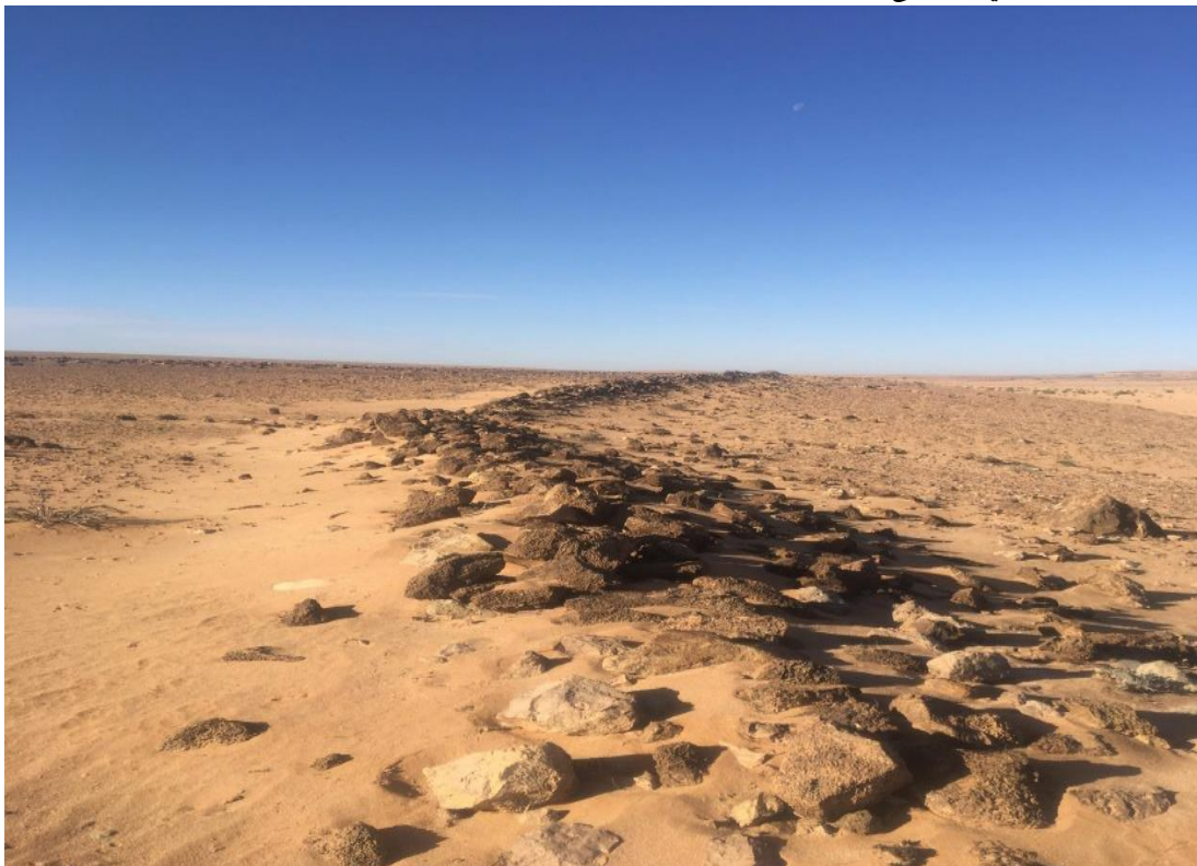
الصورة (1) سد توجيه مياه الأمطار بوادي بي الكبير حتى لا تجرف المزروعات بالوادي: تصوير الباحث
