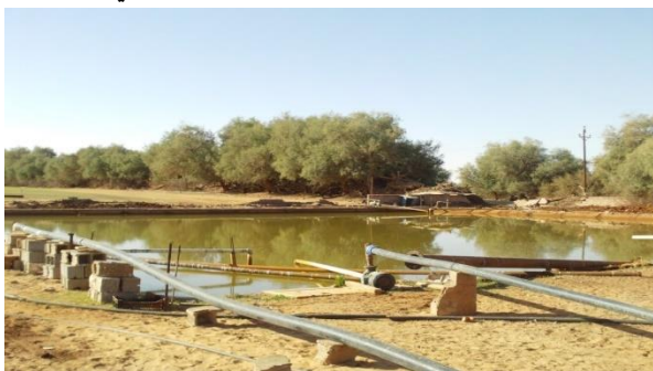
شكل 6: أحواض خرسانية سطحية مكشوفة لتجميع المياه في مشروع اشكدة (طريق تمهنت- براك)
