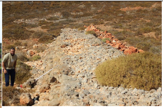
صورة (14) انهيار سد تعويقي حجري (الثاني) ، في وادي المرطوط شرق منطقة القيقب، الطول 200م × العرض 4م × الارتفاع 1.6م، منسوب الارتفاع 666م، تاريخ الصورة، 12 اغسطس 2024
