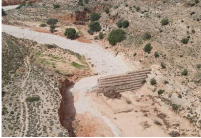
صورة (11) انهيار سد تعويقي صندوقي ، بعد سد بومنصور على الجانب الايسر (وادي سليمان)، ابعاد السد الطول 50م × العرض 10م × الارتفاع 7م ، منسوب السد 192م، تاريخ الصورة، 04 اكتوبر 2023
