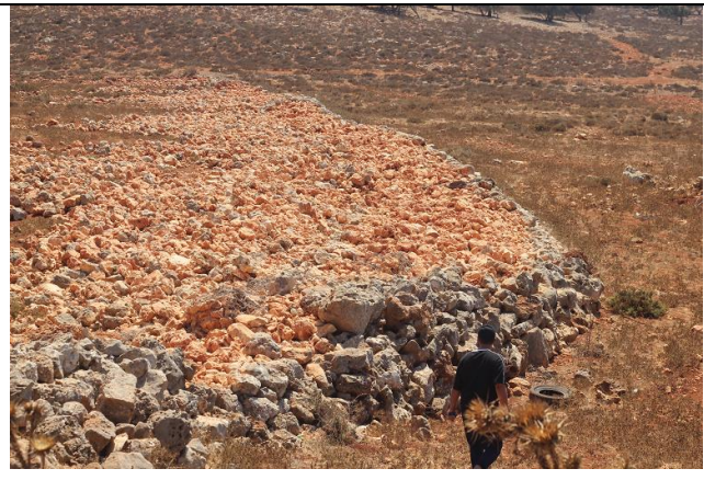
صورة (12) انهيار سد تعويقي حجري (الثاني) ، في وادي المرطوط شرق منطقة القيقب، تاريخ الصورة، الطول 200م × العرض 4م × الارتفاع 1.6م، منسوب الارتفاع 651م، تاريخ الصورة 14 اغسطس 2024
