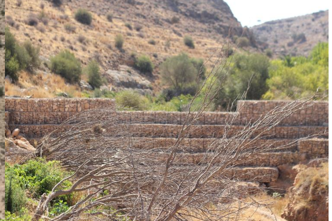
صورة (10) سد تعويقي صندوقي (قايونات) في احد روافد وادي درنة (وادي المنجر) بعد سد بومنصور على اليمين، ابعاد السد الطول 35م × العرض 6م × الارتفاع 8م، المنسوب 192م، تاريخ الصورة، 14 اغسطس 2024
