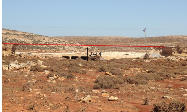
صورة (18): عبارة وادي الحمر حوض درنة جنوب منطقة القبة، ابعاد العبارة 1.5م×1.5م×30م، تاريخ الصورة 15 سبتمبر 2023
