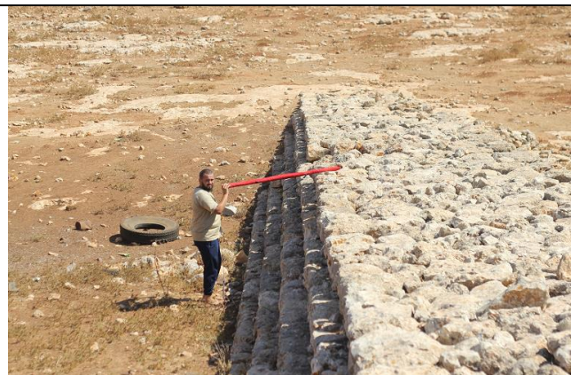
صورة (8) سد تعويقي حجري في منطقة بوذراع جنوب منطقة القبة ، ابعاد السد الطول 35 × العرض 6م × الارتفاع 8م، المنسوب 192 م، تاريخ الصورة، 12 اغسطس 2024.
