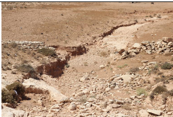
صورة (9) انهيار سد تعويقي حجري في احد روافد وادي الدواي بالقرب من الكسارة جنوب منطقة القبة ، تاريخ الصورة، 12 اغسطس 2024.
