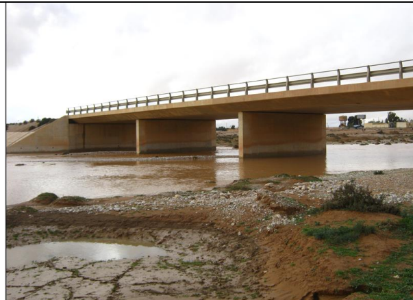
صورة (21): عبارة وادي الرملة في منطقة المخيلي، ابعاد العبارة 45م×7م×35م، ثلاث فتحات. رغم كبر حجمها ألا تعد غير كافية لتمرير مياه الوادي، عرض العبارة حوالي 50م
