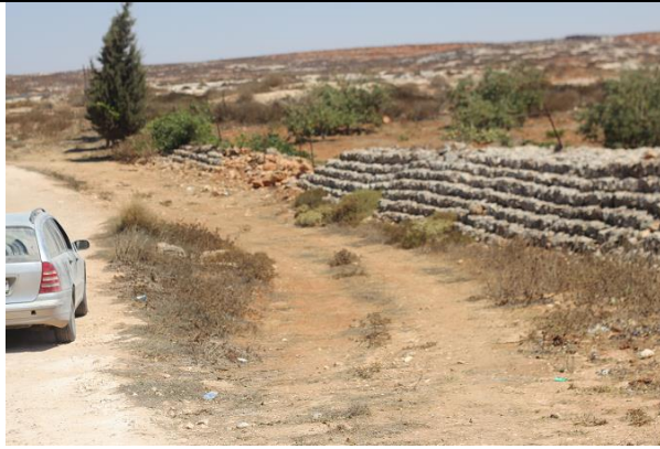
صورة (7) انهيار سد تعويقي حجري في منطقة الجباريات شرق الفايديّة مزراعة ، ابعاد السد الطول 100 × العرض 4م × الارتفاع 2م، المنسوب 192 م، تاريخ الصورة، 12 اغسطس 2024.
