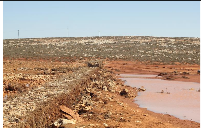
صورة (6) سد تعويقي صندوقي (قايونات) في وادي الحمر في منطقة بوذراع جنوب منطقة الملوذة، ابعاد السد الطول 350 × العرض 4م × الارتفاع 2م، المنسوب 650 م، تاريخ الصورة، 15 سبتمبر 2023
