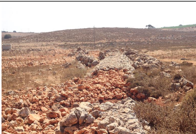
صورة (13) انهيار سد تعويقي حجري (الاول) ، في وادي المرطوط شرق منطقة القيقب، الطول 250م × العرض 5م × الارتفاع 2م، منسوب الارتفاع 666م، تاريخ الصورة، 14 اغسطس 2024
