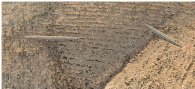
شكل 12: تكون اخاديد وانابيب تحت السد التعويضي جنوب مراوة
