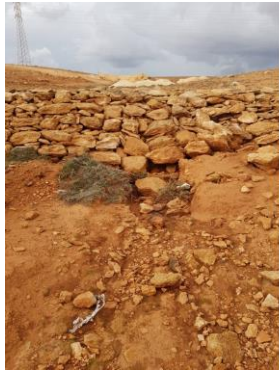
شكل 11: اخاديد اسفل السدود الحجرية، جنوب مراوة
