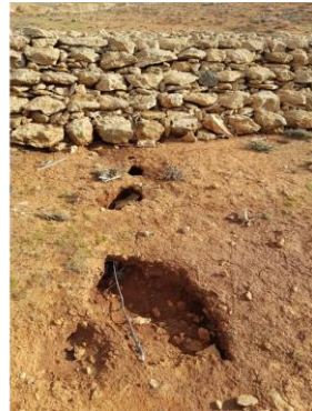
شكل 11: اخاديد اسفل السدود الحجرية، جنوب مراوة
