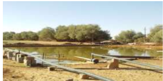
صورة (1) خزانات سطحية خرسانية مكشوفة لتجميع المياه
