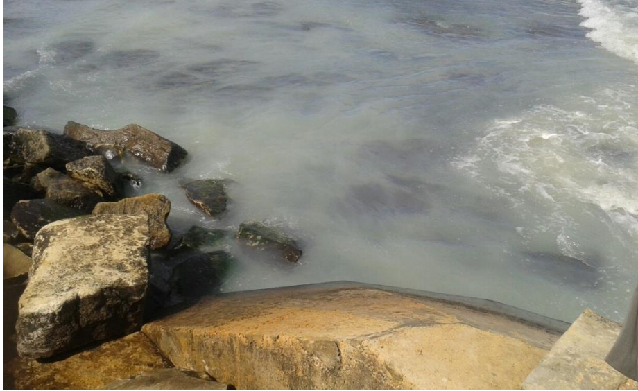
شكل رقم ( 5 - 1) تبين مدى انتشار العوالق والملوثات حول فتحة تصريف مياه الصرف الصحي بمنطقة رقم 2
