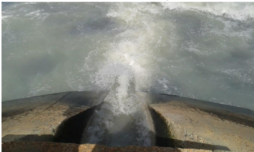
شكل (4-2) صورة تبين فتحة تصريف مياه الصرف الصحي بمنطقة رقم 2 بالقرب من جزيرة الدوران
