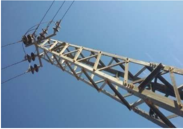
شكل (2) تركيب العناصر المعدنية للحصول على مقطع اكبر
