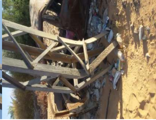
شكل (1) انحناء صافي في عمود مركب
